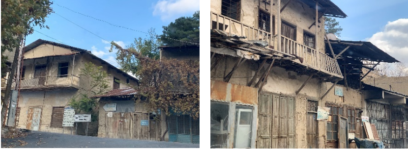
Şekil 10. İbrahimpaşa Mahallesi, zemin katları atölye, işlik, üst katları konut olan örnekleri (yazar arşivi, 2022).
