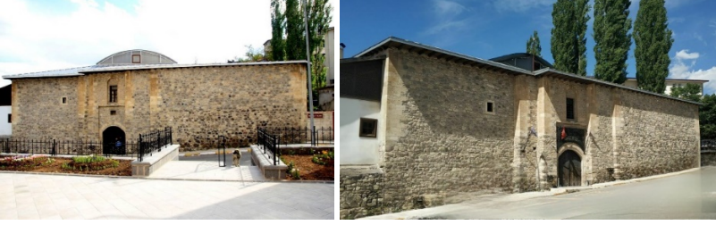
Görsel 3.3.1.Millet Hanı Ön Cephe Görsel 3.3.2.Millet Hanı Arka Cephe
