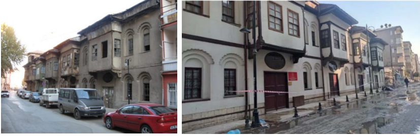
Şekil 15. Malatya merkez beş konaklar; onarım öncesi, yılında onarıp kullanılma açılan ve 2022 yılındaki 7.7 ve 7.6 büyüklüğündeki yıkıcı depremlerde ayakta kalan geleneksel Malatya evleri (URL 5).
