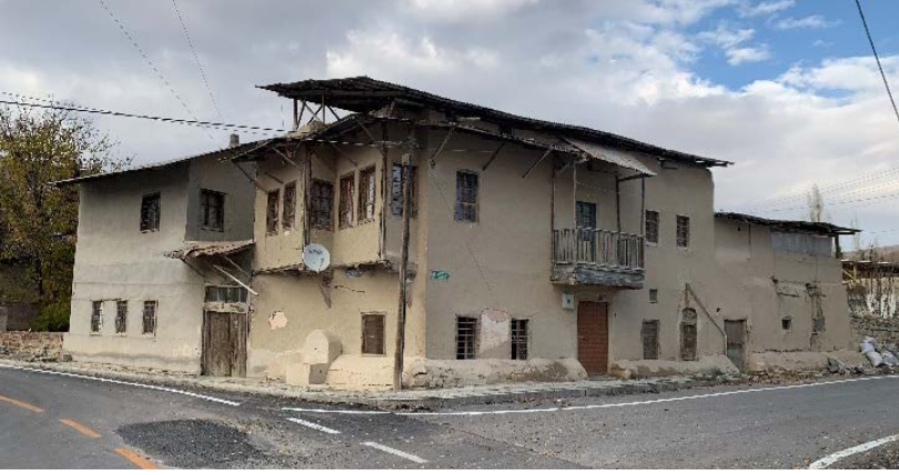
Şekil 9. Hacıderviş Mahallesi köşe parselde konumlanan kerpiç ev, bir konak yapısı kadar çok mekânlı ve iç avluludur. Her iki cephesinde sokağa bakan çıkması mevcuttur. Düz dam çatı sonraki dönemde saç malzeme ile örtülmüştür (yazar arşivi, 2022).
