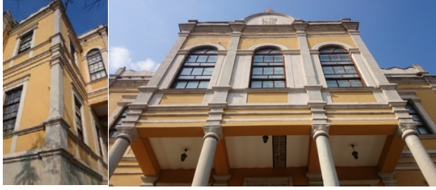
Şekil 18. Safranbolu Hükümet Konağı Kat Silmeleri, Plastr ve Sütun Düzeni
