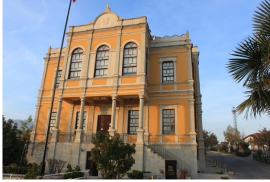
Şekil 8. Safranbolu Hükümet Konağının Güney Cephesi
