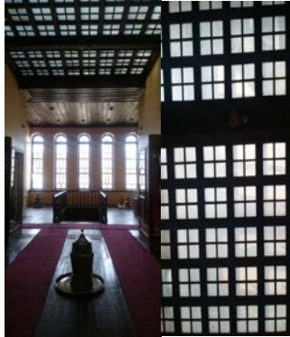
Şekil 14. Üst Kat Sofa ve Yenilenen Ahşap Çatı
