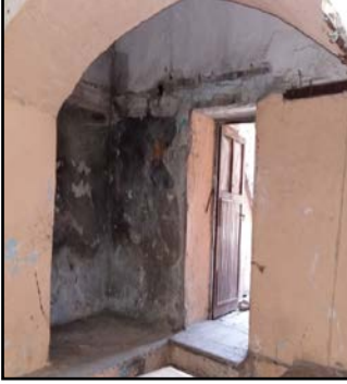
Görsel 4. Beyseri Hamamı Giriş Bölümü
