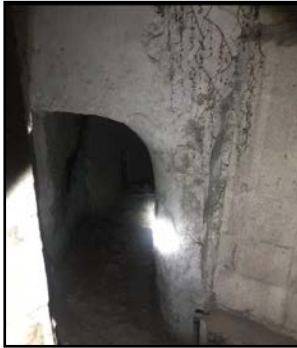
Görsel 10. Beyseri Hamamı Helâ Bölümü
