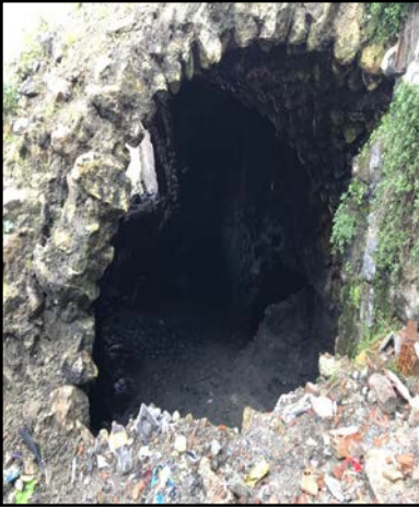
Görsel 16. Beyseri Hamamı Külhan Bölümü Genel Görünüm
