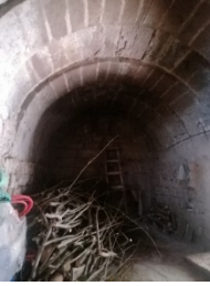
a) Ahırdan Görünüm
