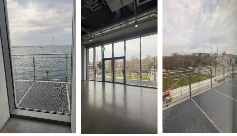
Şekil 18. Yürüme Yolu ve Galvanize taban ızgarası (Kılınç Gilisırhaoğlu, 2024 fotoğraf arşivi)
