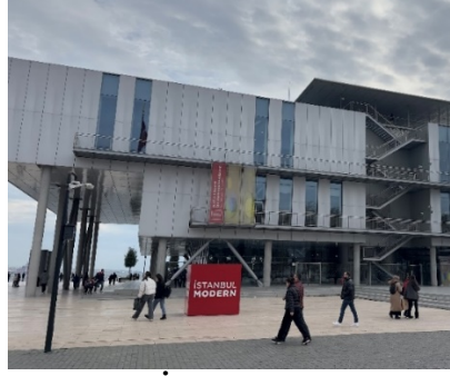
Şekil 4. İM Kuzey Cephe Görünümü (Kılınç Gilisiralıoğlu, 2024 fotoğraf arşivi)
