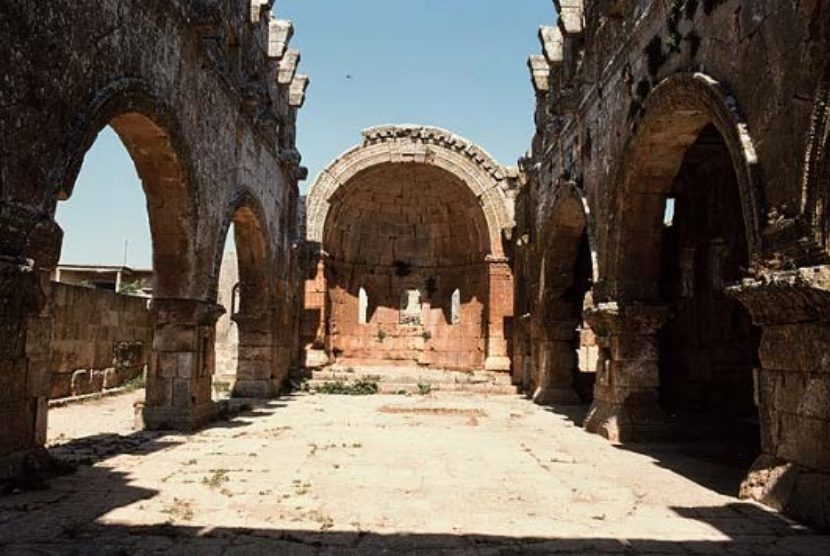
Şekil 5. Kalb Lozeh Kilisesi iç mekân görünümü (URL-2)
