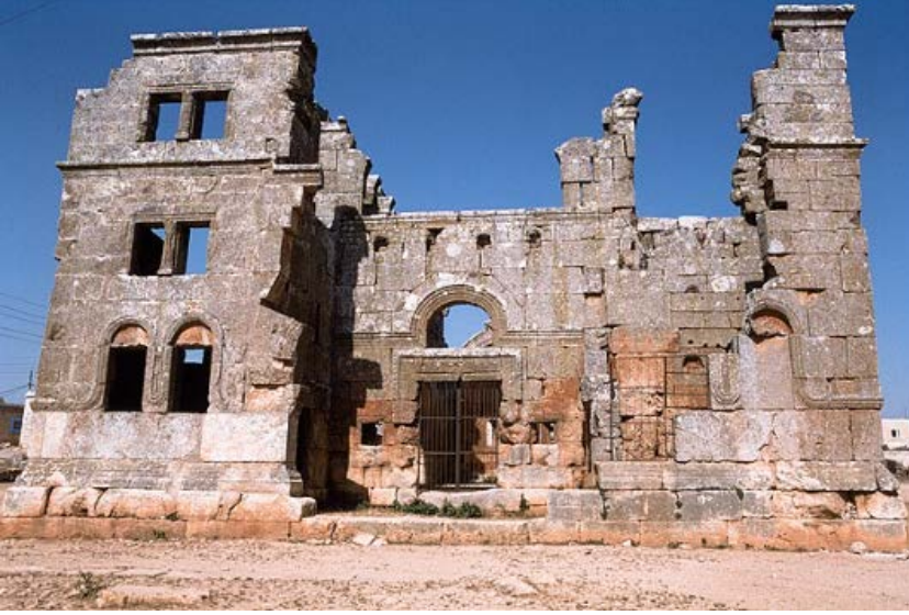
Şekil 7. Kalb Lozeh Kilisesi batı cephesi (URL-2)
