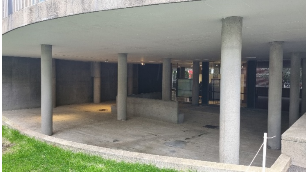
Şekil 7. Carpenter Görsel Sanatlar Merkezi'nde taşıyıcı kolonlar (yazarın kişisel arşivinden, 2024)
