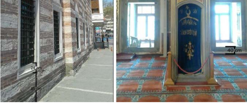
Resim 4. Sinan Paşa Camii'nde duvarda, sütun elemanlarında ve kemer açıklıklarındaki gergilerde kullanılan malzeme ve kaba ölçüleri.
