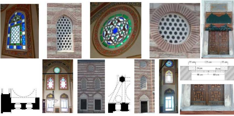
Resim 7. Sinan Paşa Camii kapı ve orta ve üst sıra pencerelerinin görünümü
