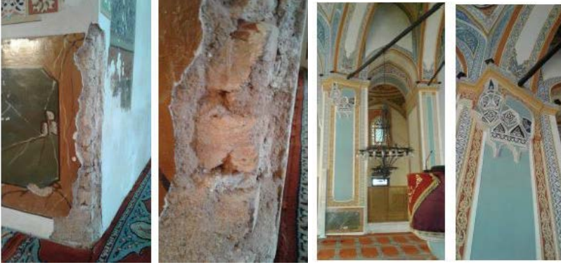
Resim 5. Sinan Paşa Camii, eski son cemaat yerinin harime katılmasıyla birlikte dönüşen ait taşıyıcı ayaklarda tuğla-taş örgü tekniği.
