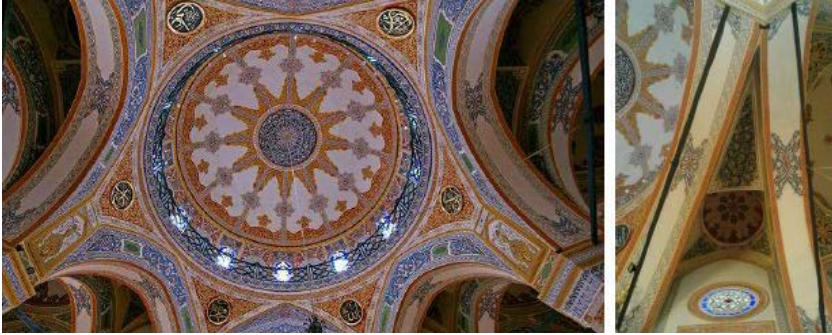
Resim 6. Sinan Paşa Camii'de kullanılan kalemişi pandantifler, geçiş kuşakları ve kubbeli tonoz.
