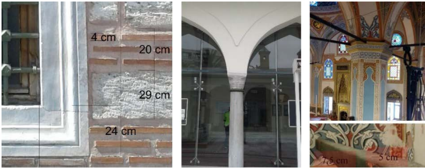
Resim 3. Sinan Paşa Camii'nde duvarda, sütun elemanlarında ve kemer açıklıklarındaki gergilerde kullanılan malzeme ve kaba ölçüleri.
