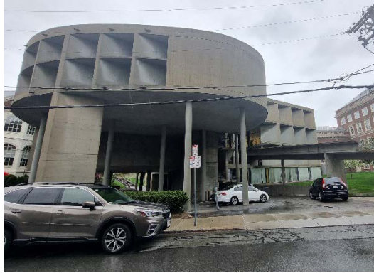
Şekil 3. Carpenter Görsel Sanatlar Merkezi genel görünüm (yazarın kişisel arşivinden, 2024)
