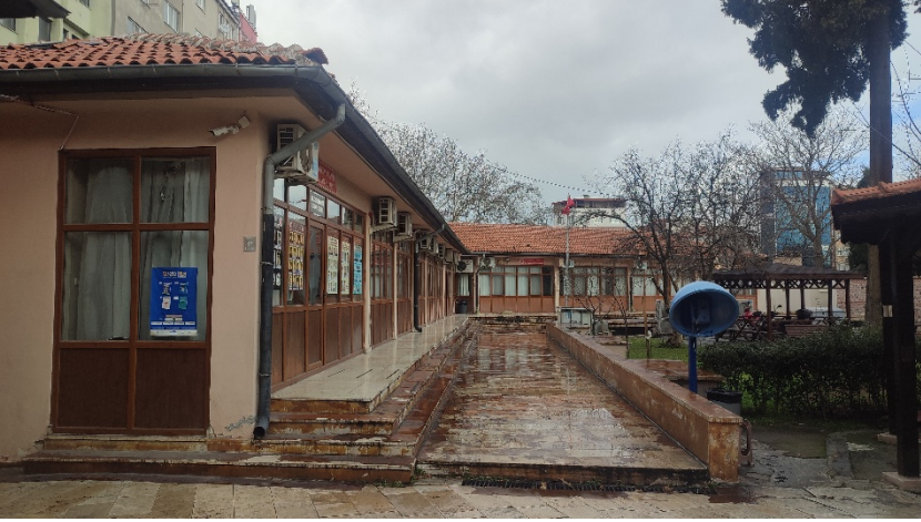
Fotoğraf 3. Balıkesir Yıldırım Cami Medresesi, ön cephe genel görünüm.
