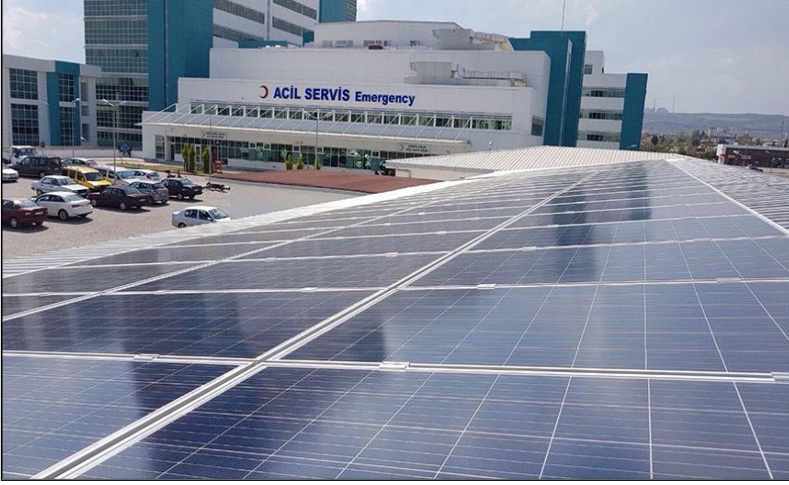
Şekil 7. Antalya kamu hastaneleri birliğine bağlı Kepez Devlet Hastanesine kurulan 17.16 kilovatlık (kW) güneş panelleri
