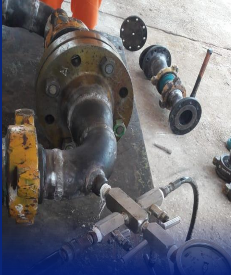
Pruebas no destructivas e hidrostáticas.
