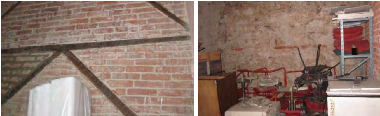
Figura 11.12 Materiales de los muros y/o paredes de la Villa “Santa Inés”.
