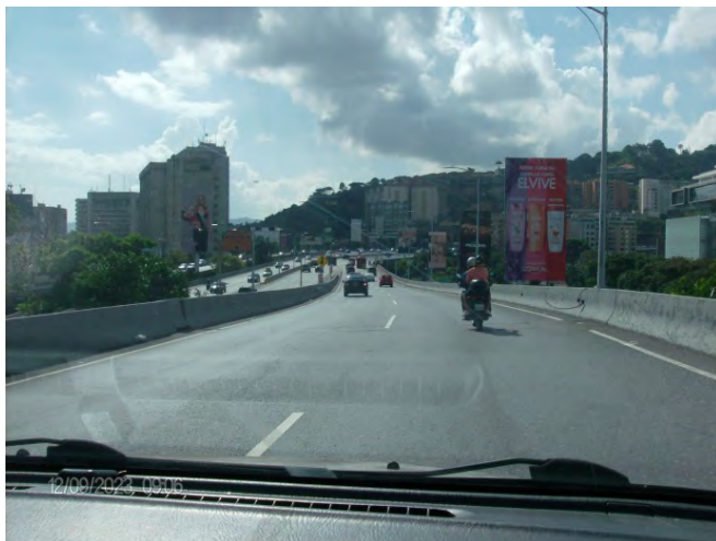
Figura 0.35 Distribuidor “El Ciempies”, vía elevada de dos canales desde Chacao a la Autopista Prados del Este.
