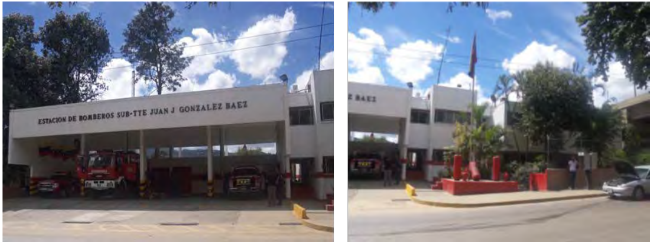
Fachada principal de la Estación de Bomberos de El Valle. Izquierda, modulo de doble altura y escaleras. Derecha, modulo administrativo y dormitorios.
