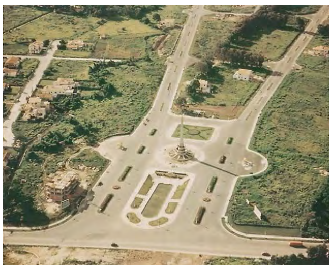
Figura 0.24 Plaza El Obelisco y avenidas aledañas en construcción en Altamira, 1945.
