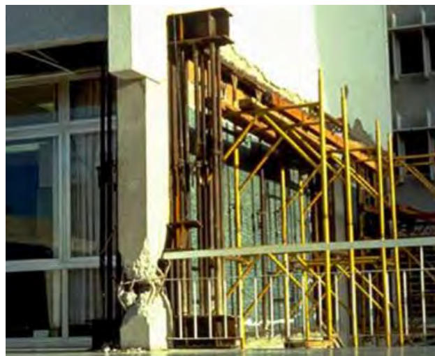
Daños en columnas. Izq. (Bertero, 1967). Der. (Steinbrugge, 1967) Figura 7.8
