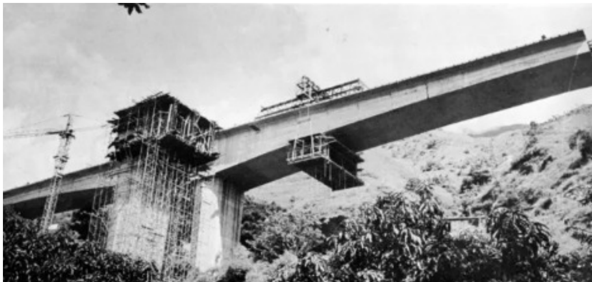
Construcción de los viaductos sobre el sector Los Chorros en la Avenida Boyacá.
