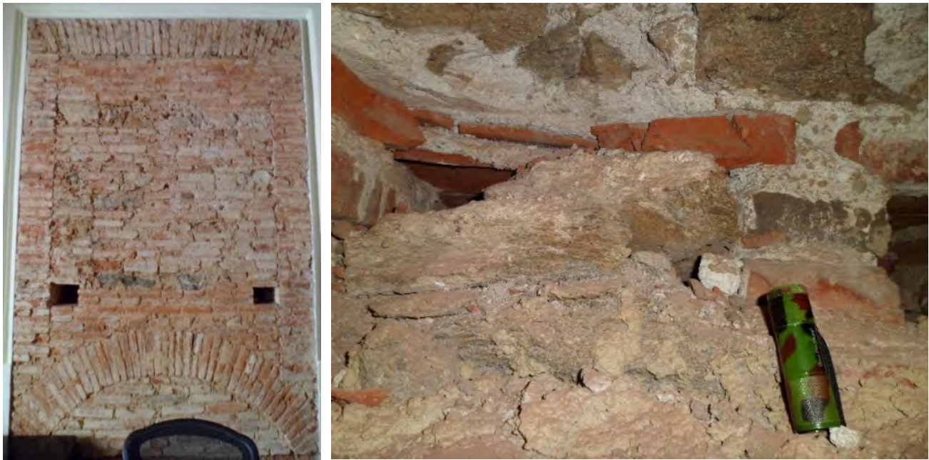
Figura 11.18 Materiales de los muros y/o paredes de la Casa Amarilla “Antonio José de Sucre”.
