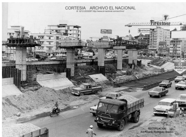
Trabajos de construcción del segundo piso de la Autopista del Este (hoy Cacique Guaicaipuro) en la década de los 70.
