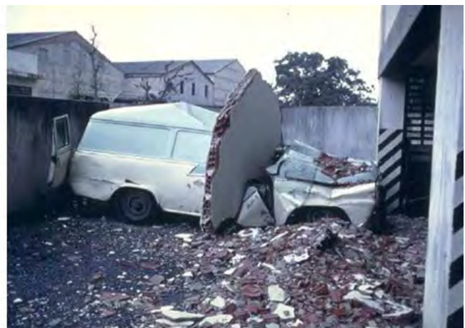
Caída de paredes enteras hacia áreas exteriores del edificio Izq. (Steinbrugge, 1967). Der. (Milek, 1967)
