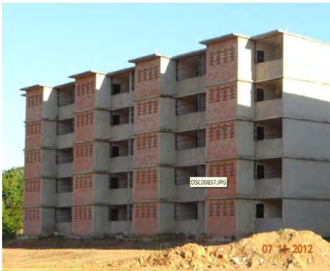
Edificio con muros de concreto armado en dirección transversal y sin muros en dirección longitudinal (Ver Capítulo 9).
