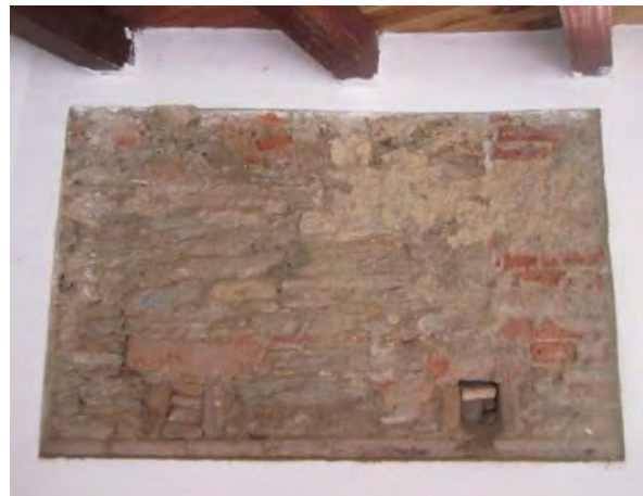
Figura 11.6 Materiales de los muros y/o paredes de la Casa de Campo “Antonio Guzmán Blanco”.
