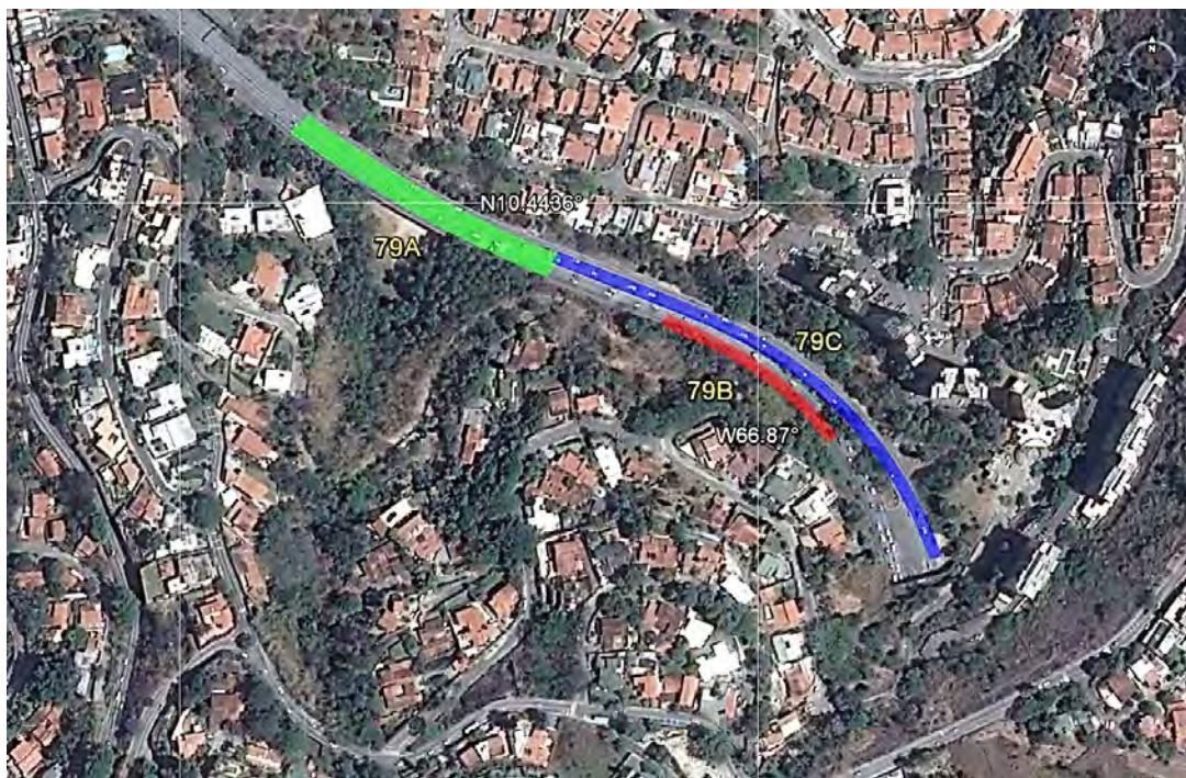
Figura 14.19 Ubicación de los puentes del Tramo Elevado Club Hípico.
