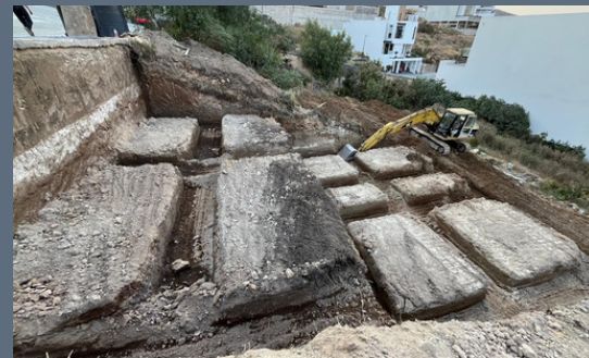
Casa Residencial - Fraccionamiento Vilas
