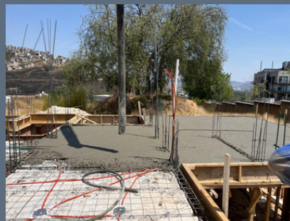
Colado de Losa
