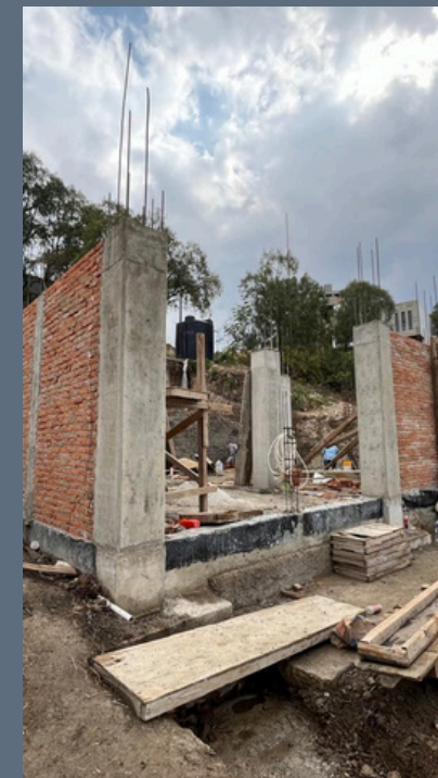
Excavación y Cimentación
