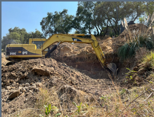
Excavación y Nivelación
