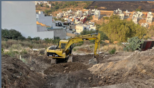
Excavación y Cimentación
