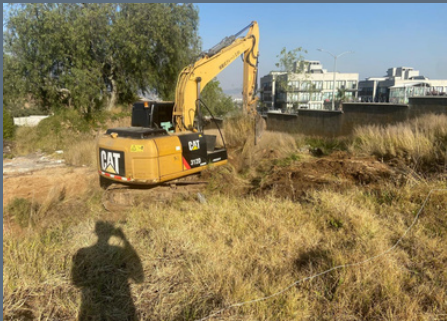
Limpieza y Nivelación de Terreno
