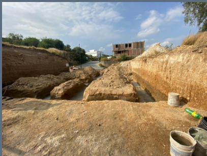
Trazo y Excavación de Cepas
