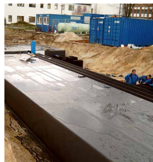
Dichtheitsprüfung an den Ecken
