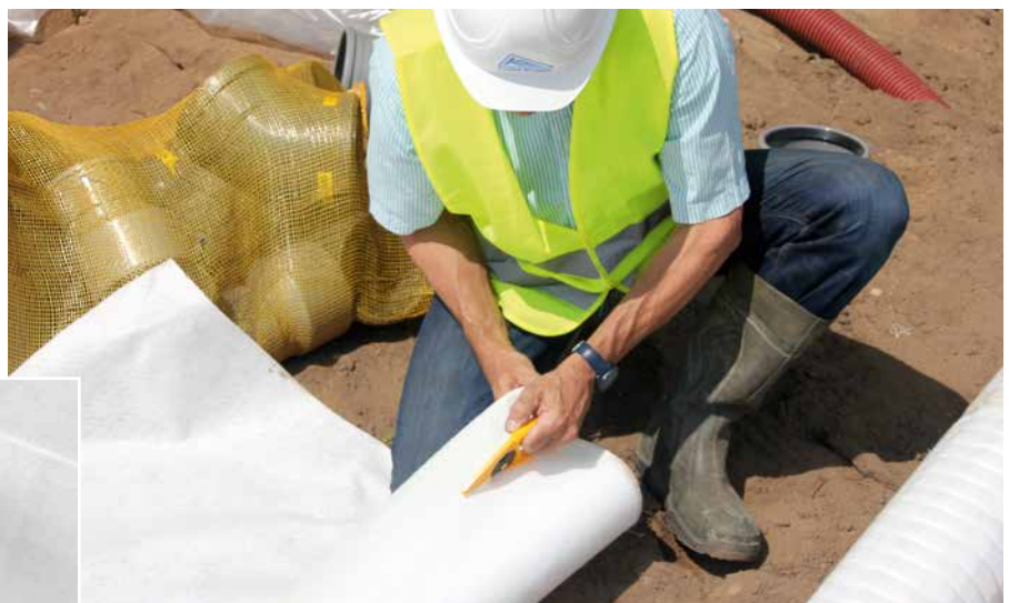
Zuschnitt des Filtrervlieses mit dem Funke Filtrervliesschneider
