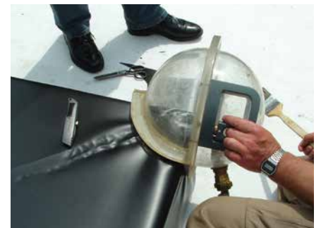
Dichtheitsprüfung an den Ecken
