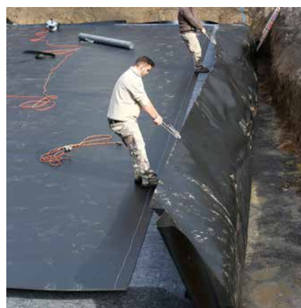
Großanwendung mit Folienummantelung
