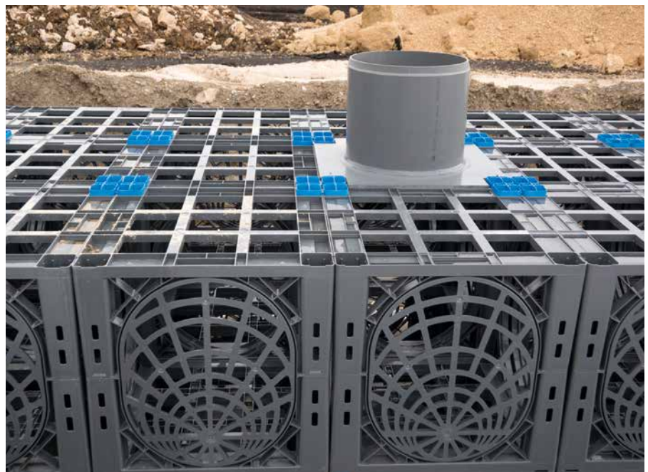
> Inspektionsblock mit Steigrohranschluss DN 400 zur Wartung
