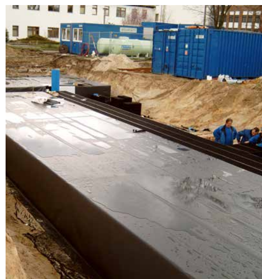
Dichtheitsprüfung an den Ecken
