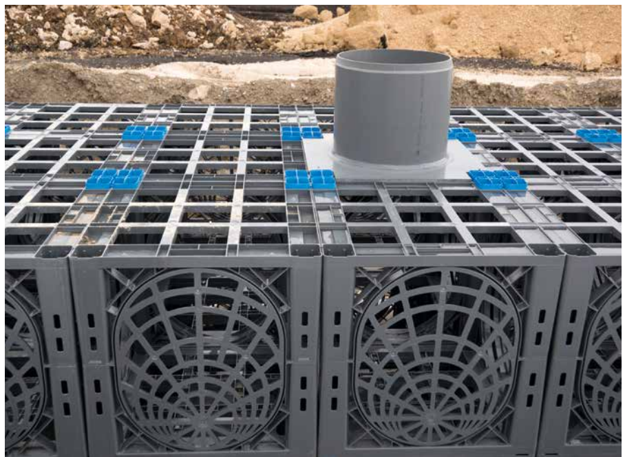
> Inspektionsblock mit Steigrohranschluss DN 400 zur Wartung
