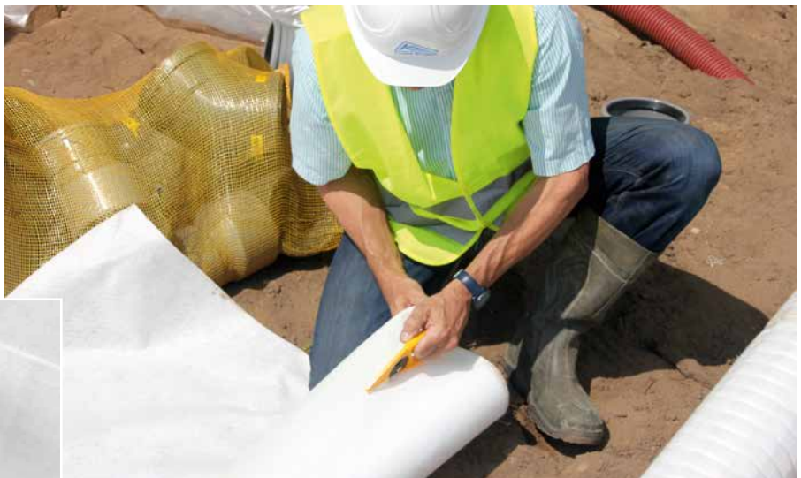
Zuschnitt des Filtervlieses mit dem Funke Filtervlieschneider
