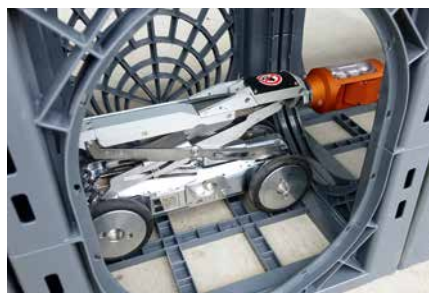
> Kamerabefahrung ohne Inspektionsschiene
