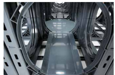
> Inspektionstank zur Kamerabefahrung
