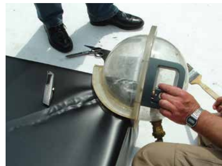
Dichtheitsprüfung an den Ecken
