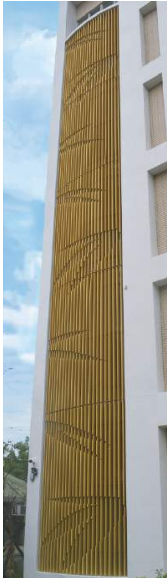
彰化 外牆切割格柵
