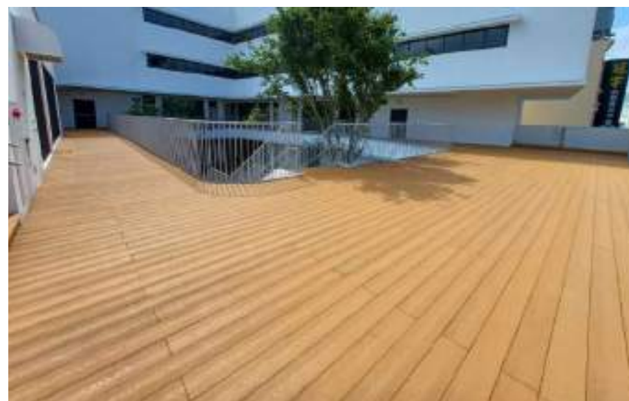
彰化 大樓平台
