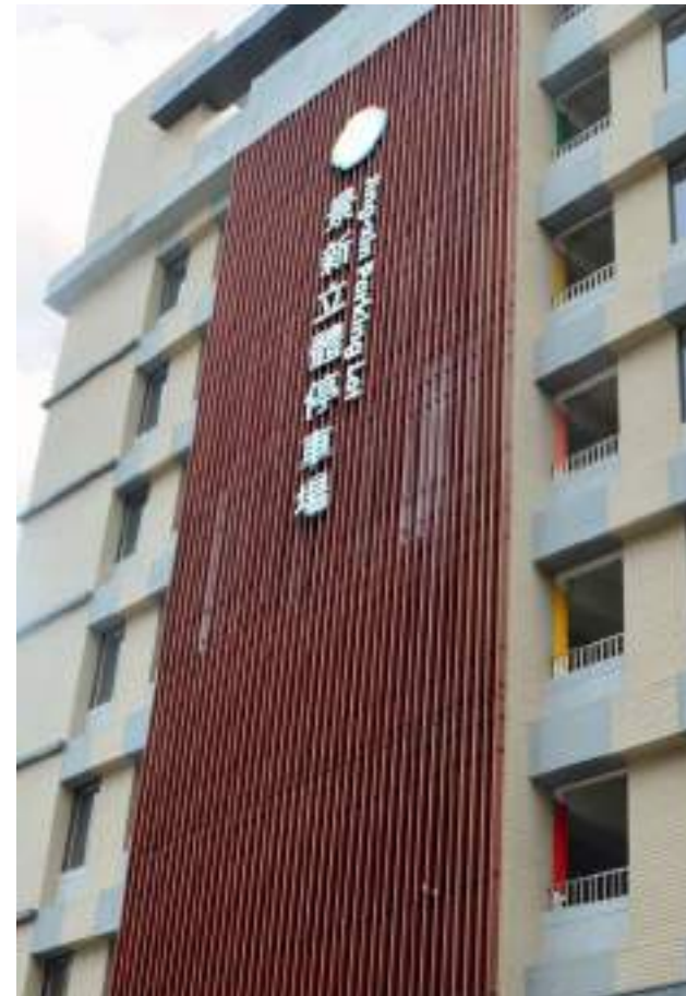
台北 立體停車場外牆格柵
