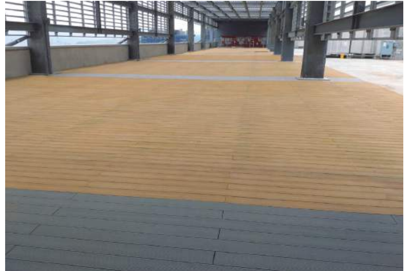
新北 物流中心頂樓平台
