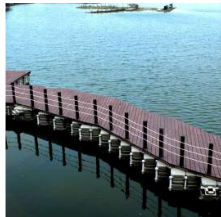
桃園 水上浮箱景觀平台
