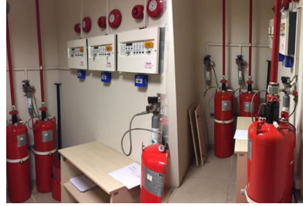
Resim 25- FM200 çalışma prensibi ve örneği
