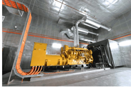
Resim 8- Kabinsiz Dizel jeneratör
