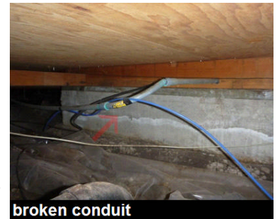
broken conduit
