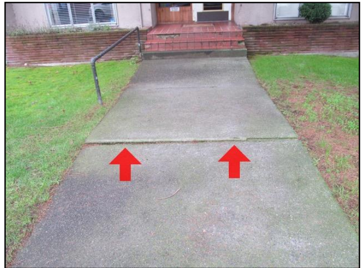
23. Possible trip hazards
