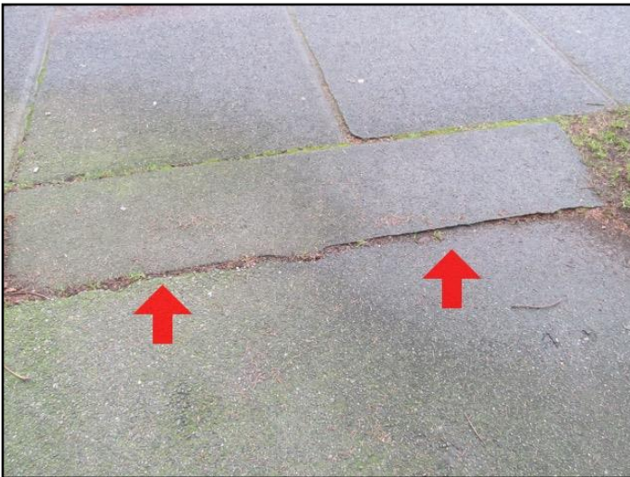
22. Possible trip hazards
