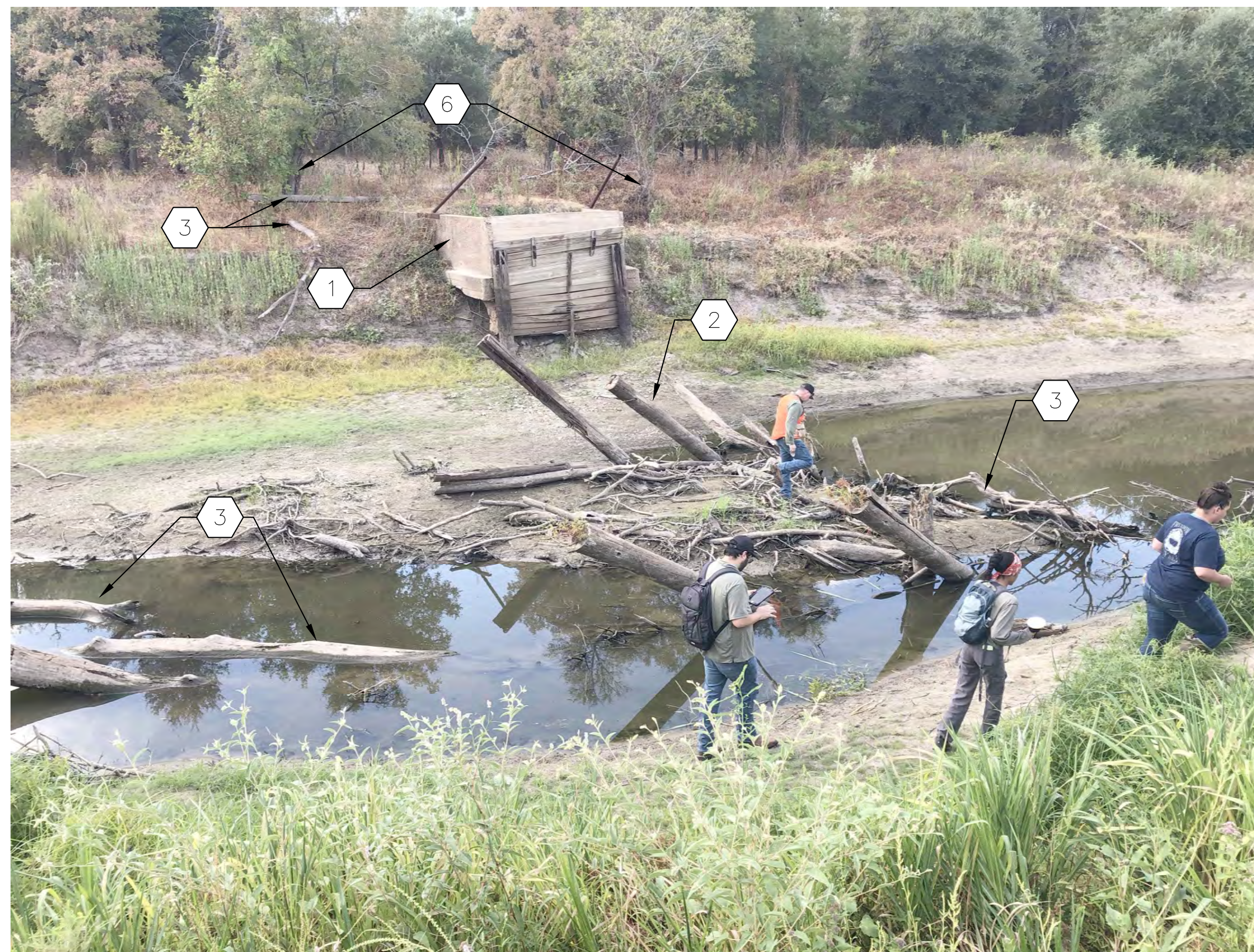
2 DEMOLITION - PHOTO #1 SCALE: N.T.S
