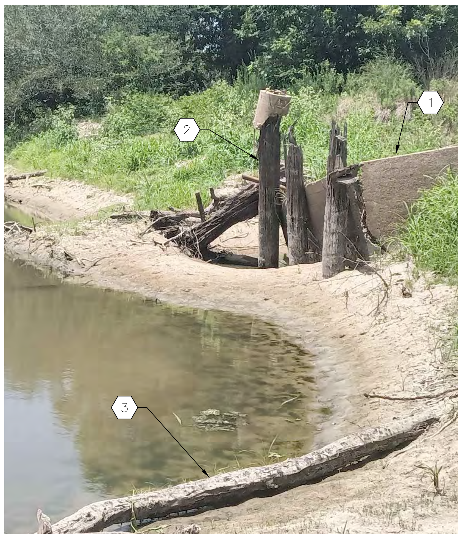
3 DEMOLITION - PHOTO #2 SCALE: N.T.S
