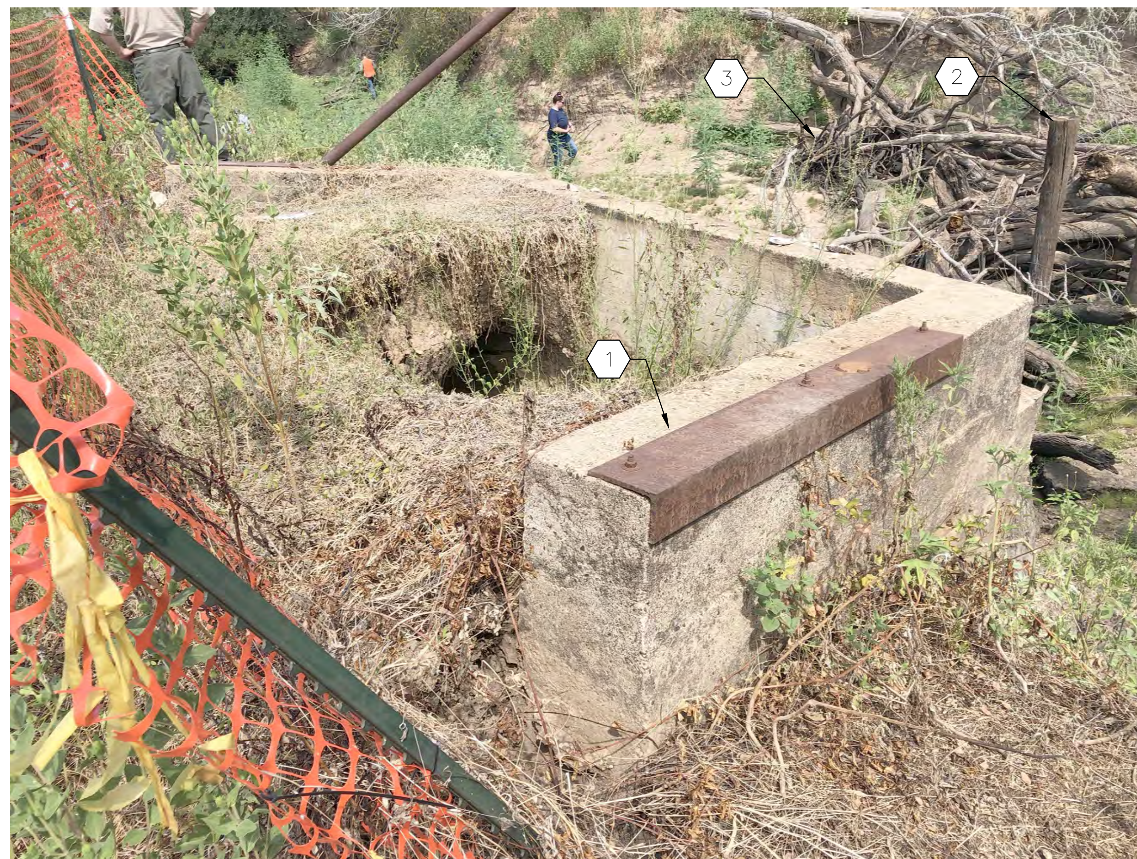
4 DEMOLITION - PHOTO #3 SCALE: N.T.S
