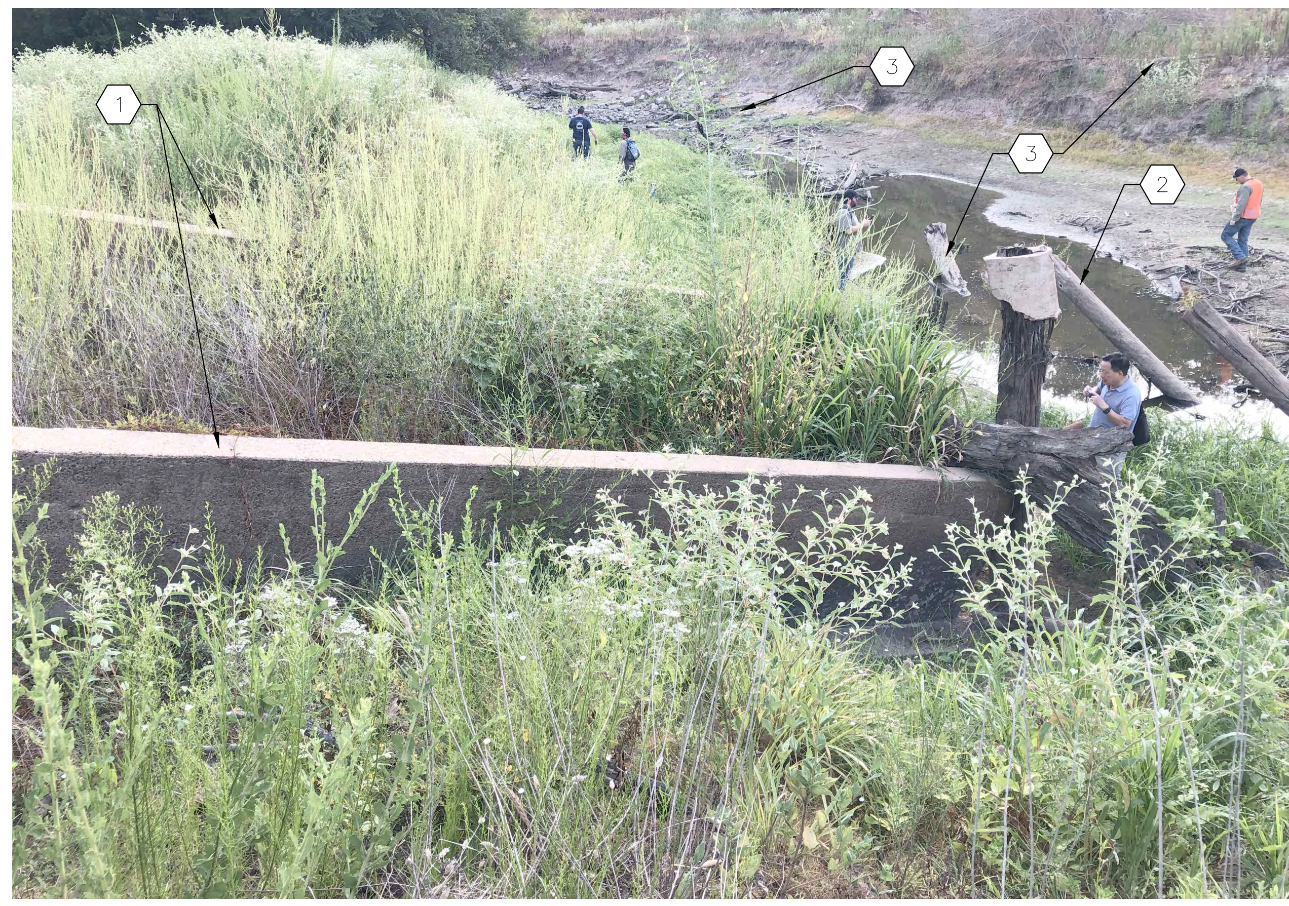
4 DEMOLITION - PHOTO #3 SCALE: N.T.S
