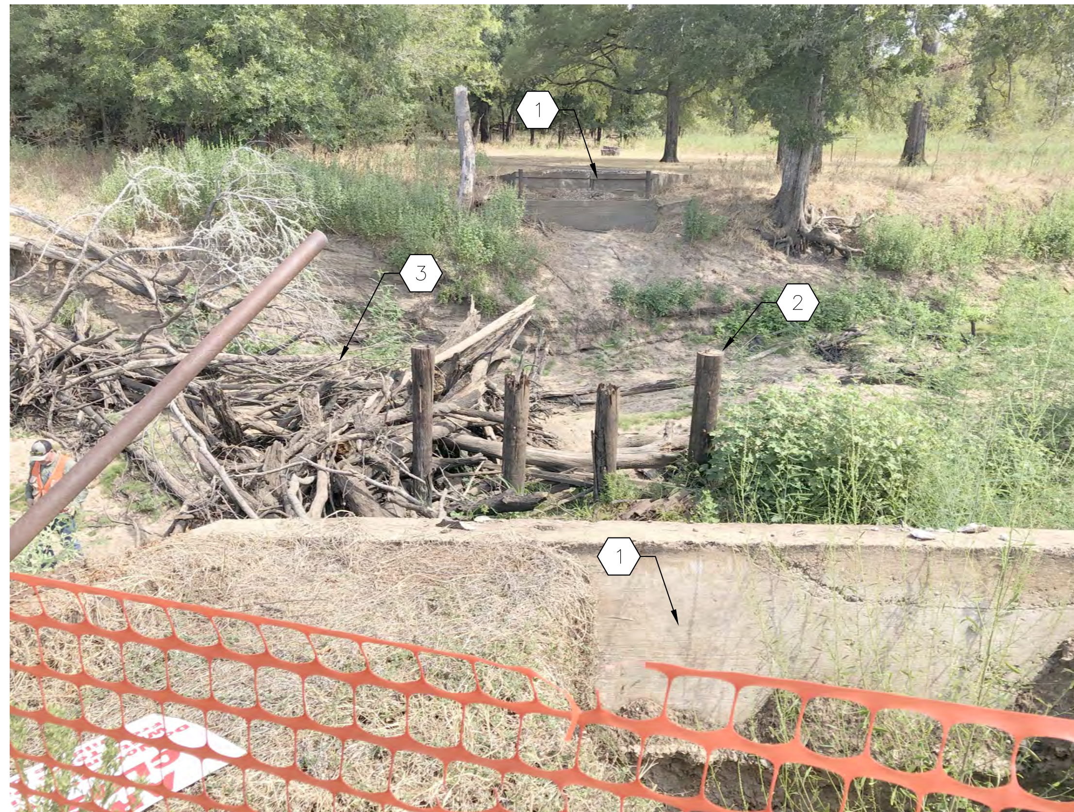
2 DEMOLITION - PHOTO #1 SCALE: N.T.S
