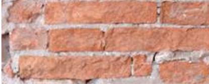
Esempio di elemento lapideo in laterizio arenaria soggetto a scagliatura
