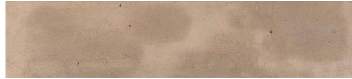
Esempio di macchie dovute a condensa
