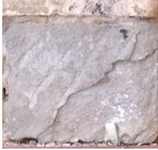
Esempio di elemento lapideo in arenaria soggetto a scagliatura
