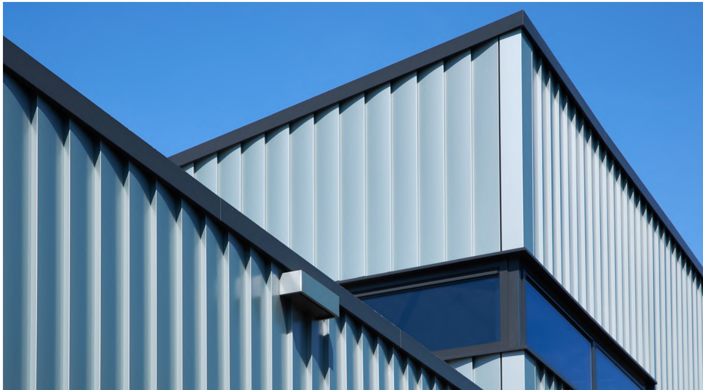
De Zwart Schoonmaak Warmond Architect: Tordoir van den Berg Architecten
