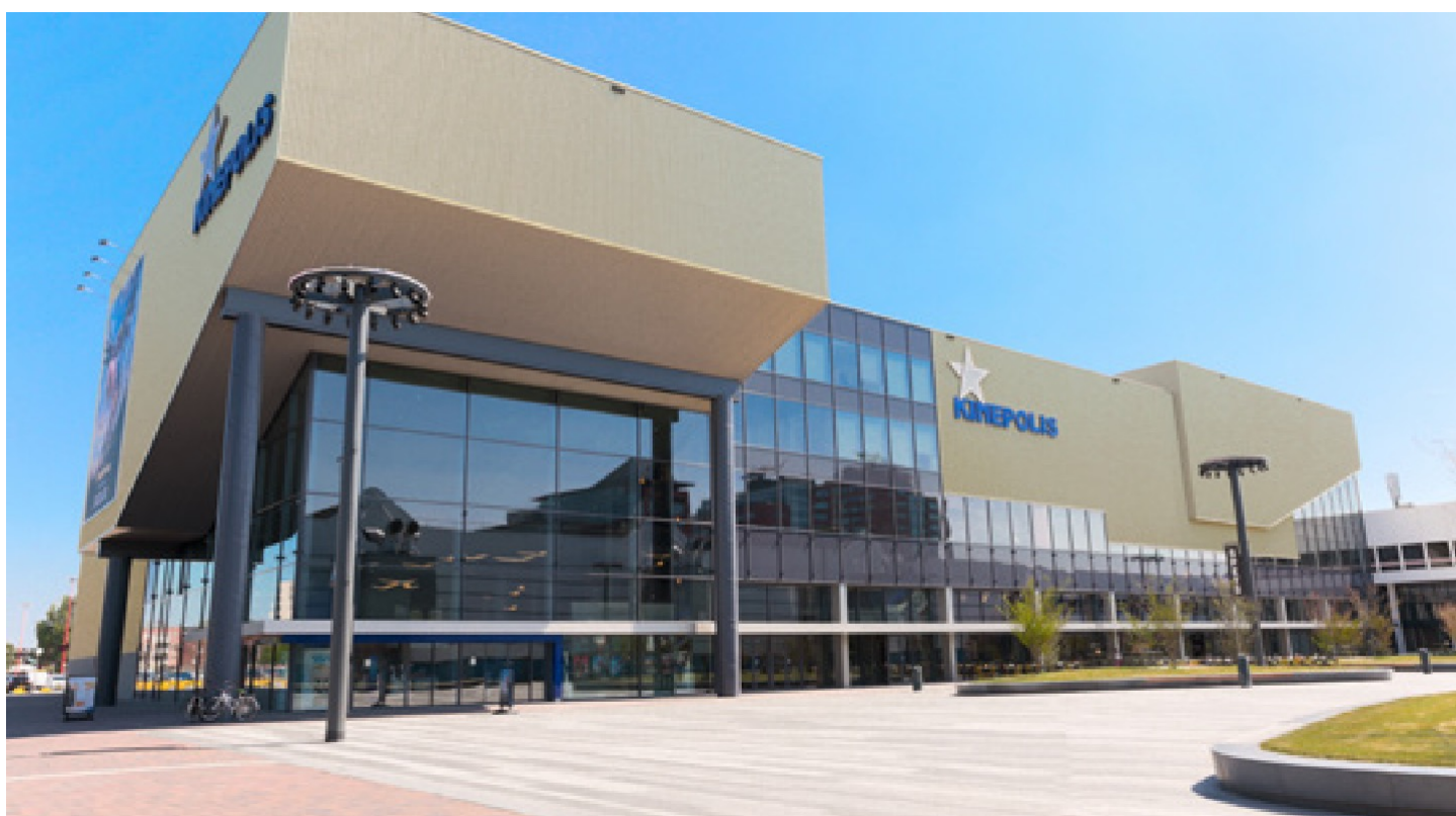
Kinepolis Utrecht - ISIS profiles Architect: Snelder Architecten
