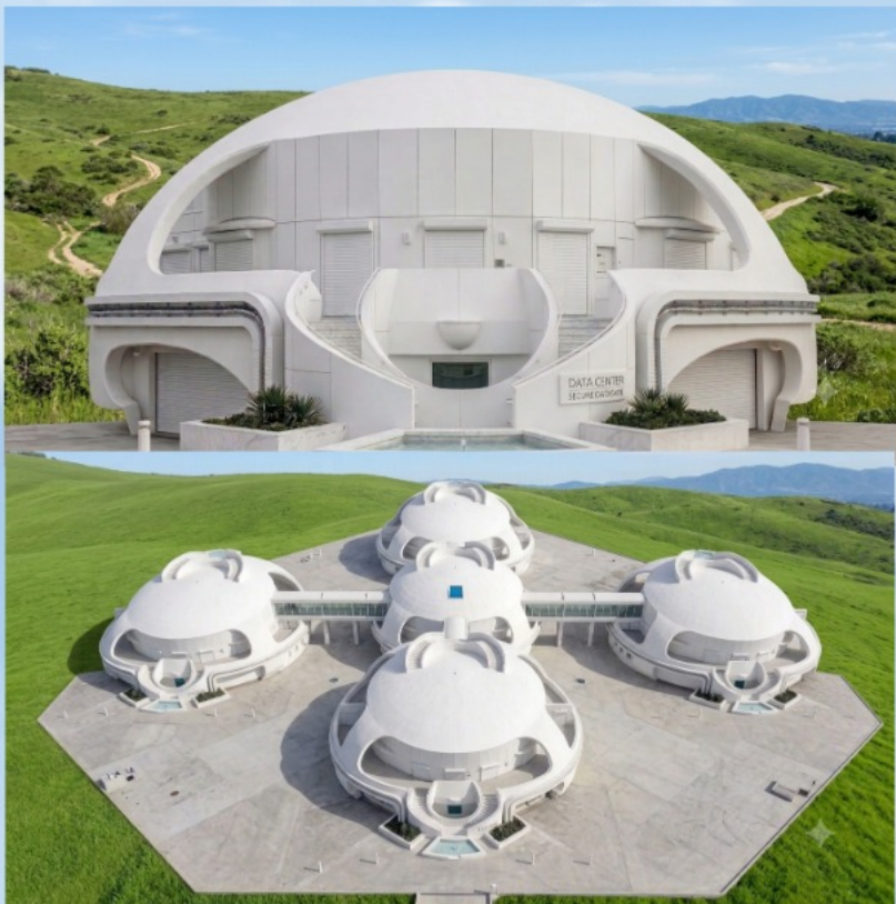
M7 Data Center
