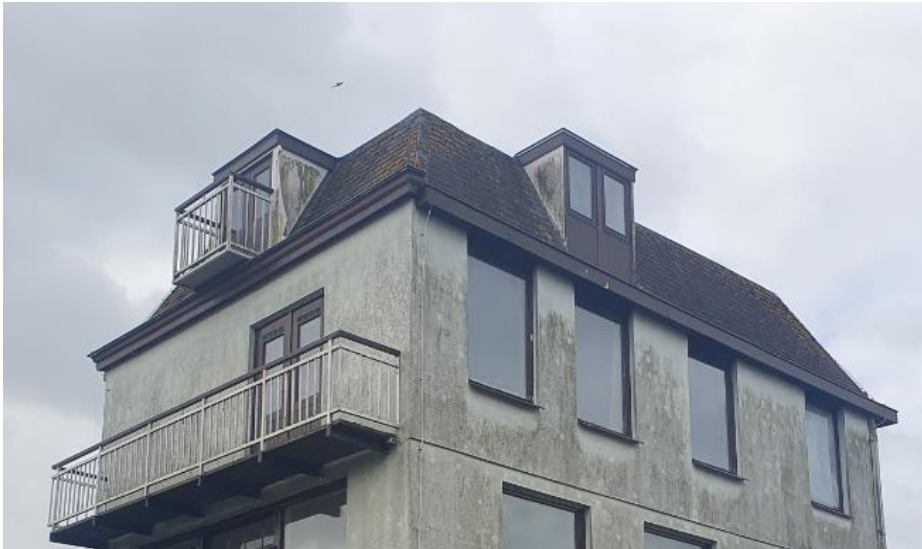
Figuur 5: Het bitumen dakvlak is volledig gesloten
