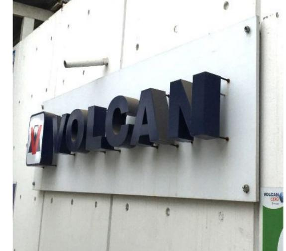
Es un panel composite formado por **dos láminas de cubierta de aluminio** y un núcleo relleno de agregado mineral **no inflamable**, sinónimo de calidad de construcción **sostenible** y los más **altos estándares** de diseño.
