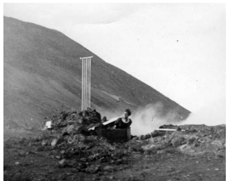
1932, Vulcarolo. 2° impianto con condotta di 300 m per la condensazione del vapore acqueo per l'alimentazione idrica all'Osservatorio. Fondo Fotografico G. Ponte
