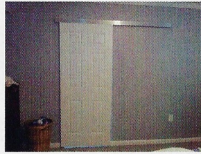
Bad barn door
