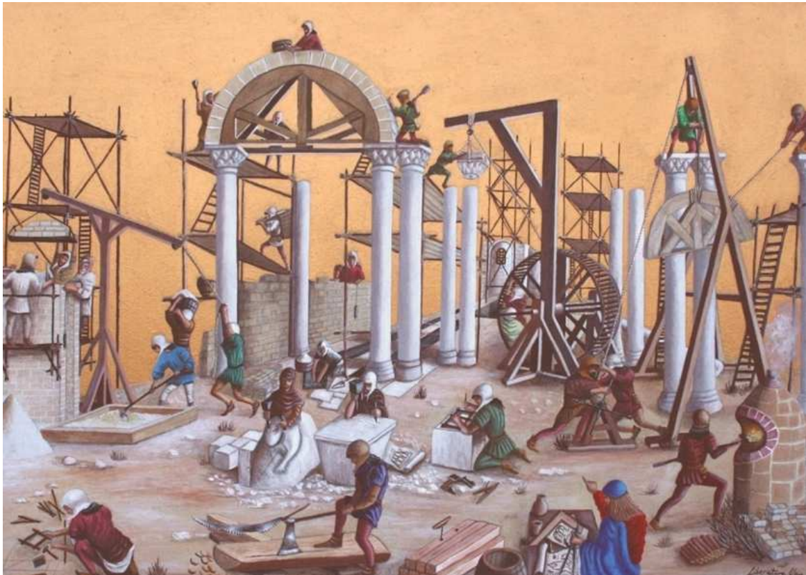
Un cantiere medievale
