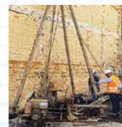
Fundação profunda em estaca - Aracaju/SE
