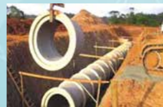
Macro drenagem - Lagarto/SE
