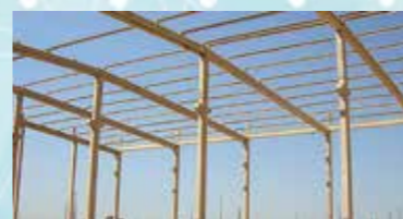
Galpão Industrial - Mossoró/RN
