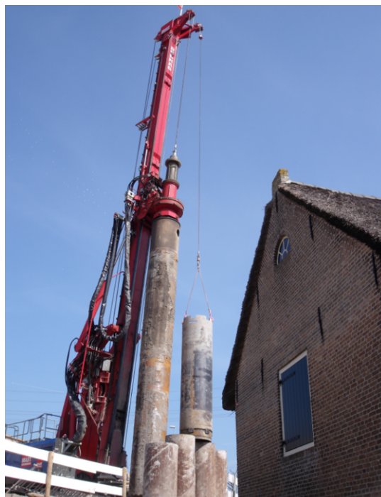
Figuur 2: Werk dicht bij de huizen
