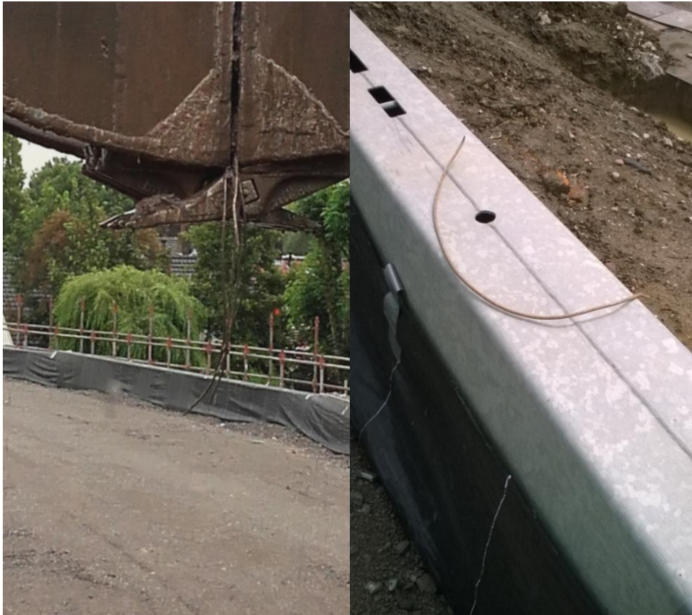
Figuur 3-21 Foto's van de strengen die opgegraven zijn bij anker A26 in sectie F1-1 (Waterschap Rivierenland, 2018)
