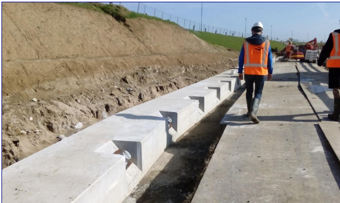
Figuur 2-46 Foto van gerealiseerde palenwand bij KIS. In beeld zijn de doorlopende betonnen gording en de verankeringskoppen. De constructie verdwijnt onder het maaiveld na het verflauwen van het binnentalud
