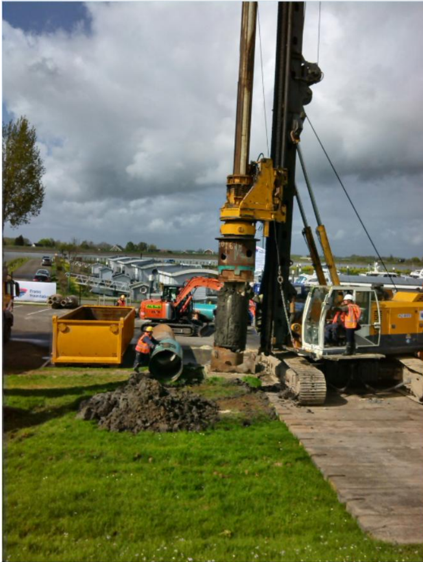
Figuur 2-60 Foto uitvoering proefpalen op een buitendijks terrein nabij jachthaven Liesveld bij Nieuw-Lekkerland (H. Larsen, April 2014)
