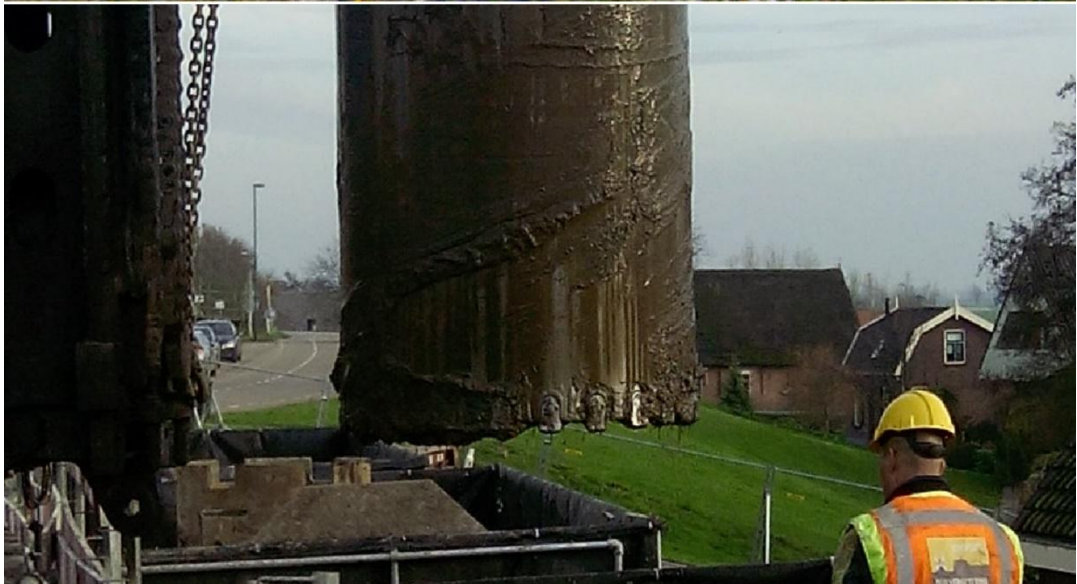
Figuur 3-18 Foto's van de booropstelling met een gladde boorcasing. Onder de boorcasing is de boorkroon te zien, die voorzien is van opgelaste 'tanden' (Waterschap Rivierenland, 2018)
