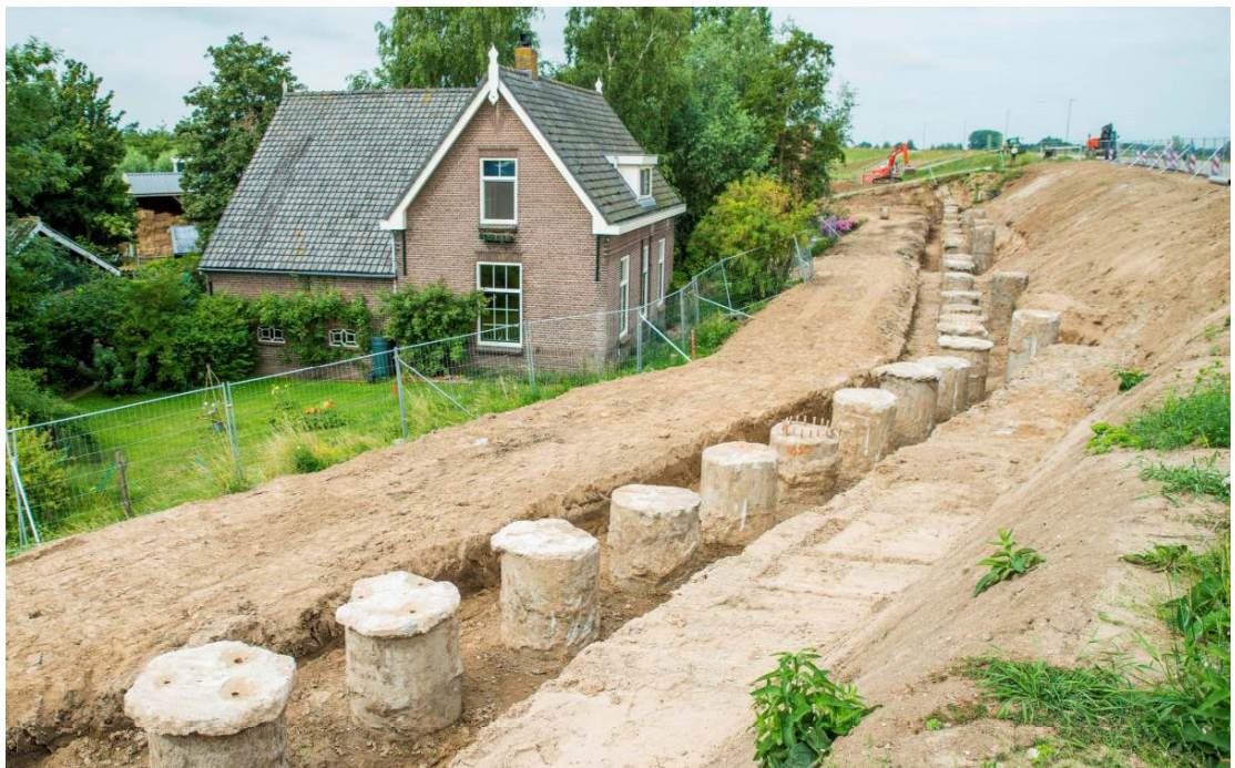
Figuur 2.1 Foto palenwand (nog zonder deksloof) (Waterschap Rivierenland, 2018)
