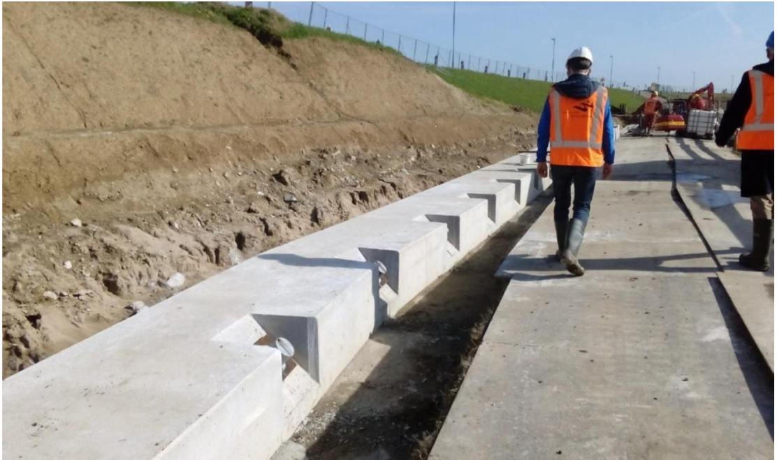
Figuur 2-57 Foto van gerealiseerde palenwand bij KIS. In beeld zijn de doorlopende betonnen gording en de verankeringskoppen. De constructie verdwijnt onder het maaiveld na het aanvullen van grond op het binnentalud
