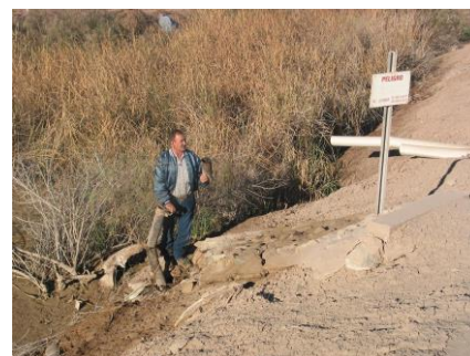
Figura 7. Colector deteriorado.
