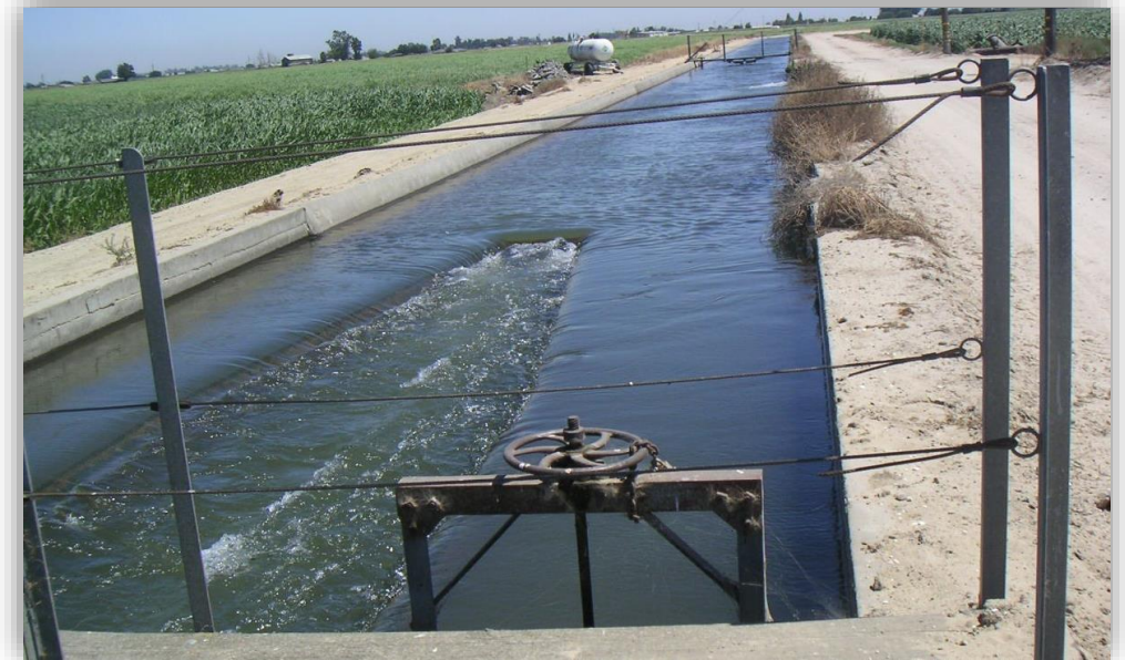
Pico de Pato en Turlock ID, California. Los sedimentos pueden ser removidos a través de las compuertas
