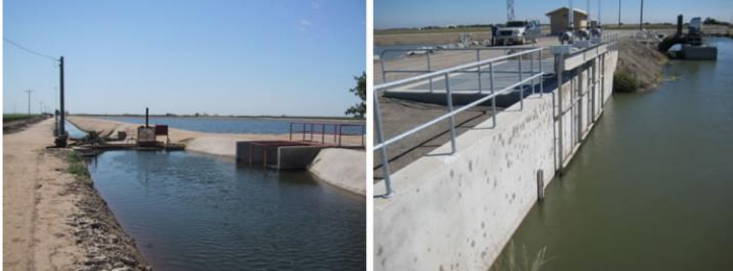
Reservorio Regulador Waldron en Distrito de Riego de Fresno, CA, USA (Burt, C. 2013)
