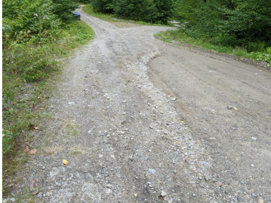
Figure 8 Extrémité du chemin Bergeron - Rigoles dans la chaussée
