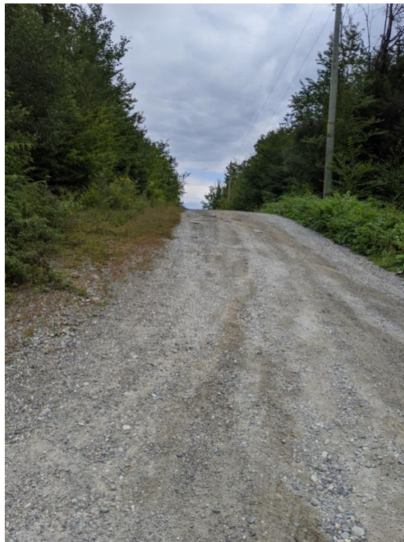
Figure 7 Extrémité du chemin Pinard - Rigoles dans la chaussée
