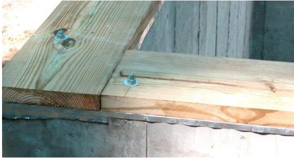
Simple sill (mud) plate
