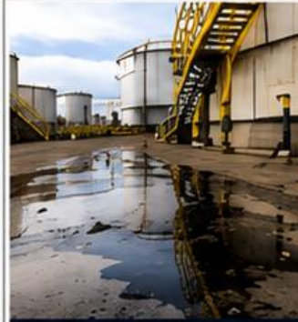
TANQUES DE ALMACENAMIENTO
