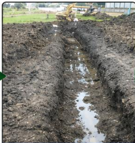
DURANTE LA INTERVENCIÓN
