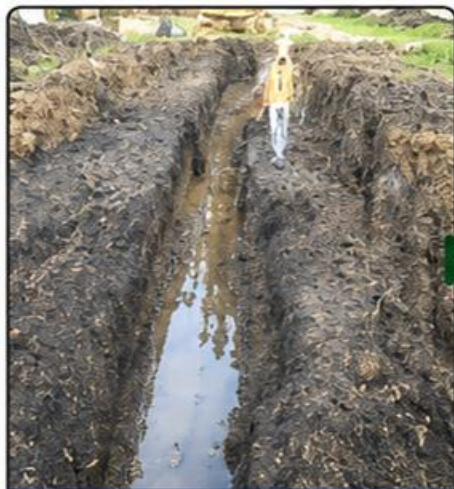
ANTES DE LA INTERVENCIÓN
