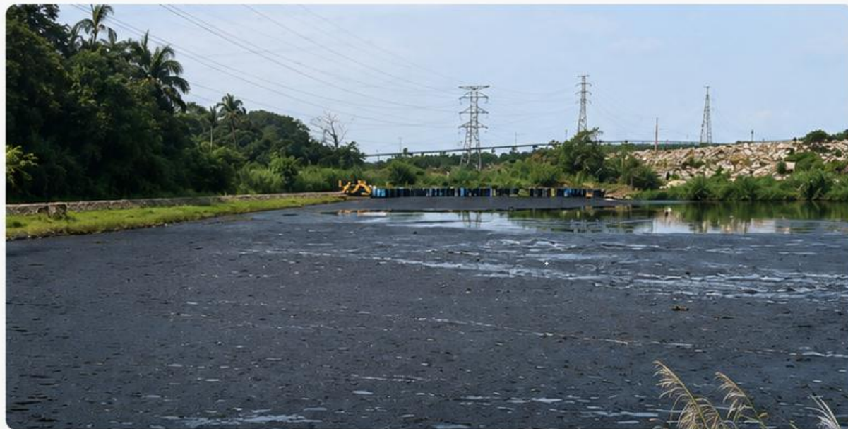
PRE-TRATAMIENTO DE LA LAGUNA MONTE ESPERANZA
