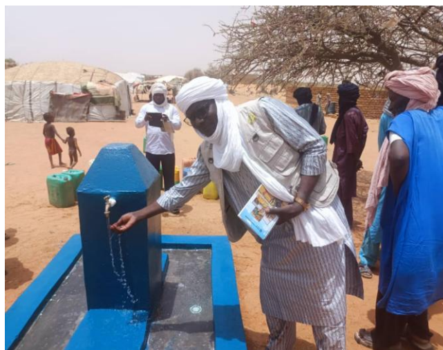
Image 2 : Gao, Borne fontaine réalisée par TASSAGHT sur un site des PDIs
