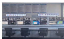
泵站测试系统
