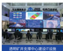
透明矿井支撑中心建设IT设施
