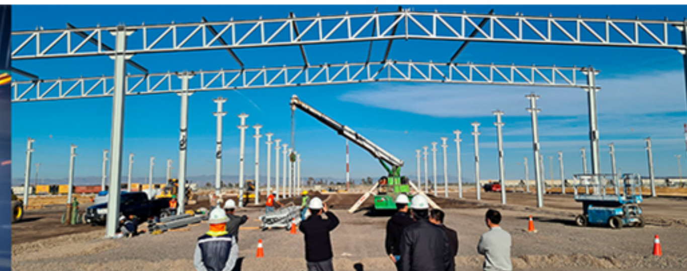
INSTALACIÓN Y MONTAJE EN SITIO
