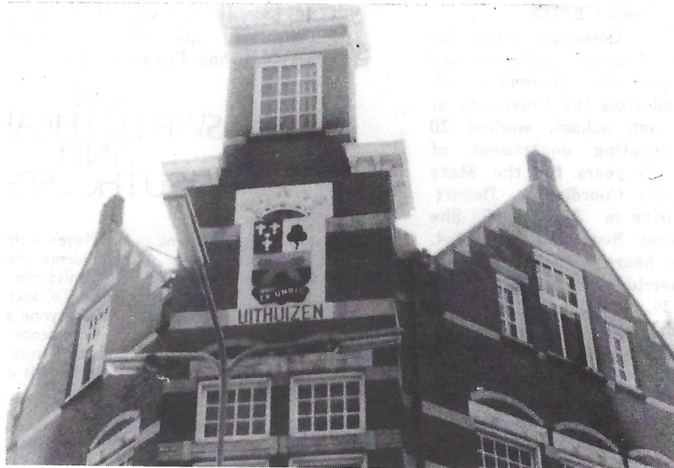
THE TOWER OF UITHUIZEN, HOLLAND
