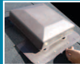
PASO 1 Remueva el ventilador existente
