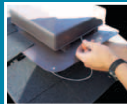
PASO 3 Pase el cable a través y reemplace el ventilador
