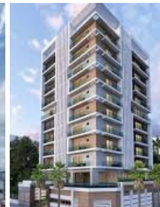
Brickell Evaristo En construccion
