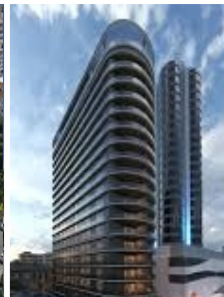
Brickell Naco En construccion
