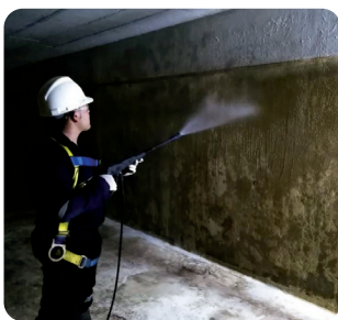
LIMPIEZA DE RESERVORIOS DE AGUA
