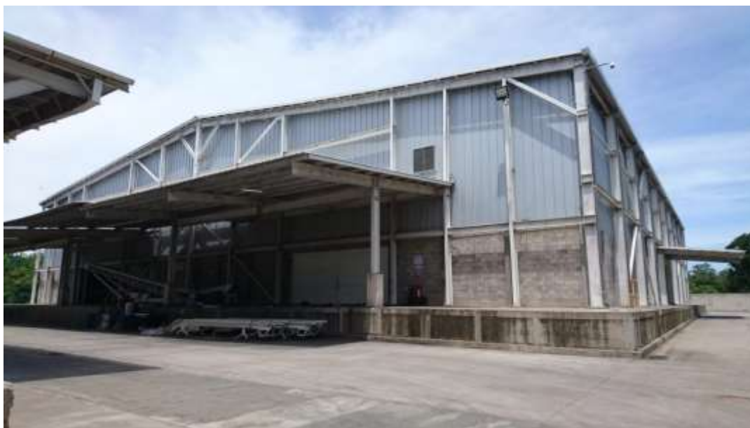
Figura 2.9 Fachada Bodega 6 – Ingenio Azucarero en estudio.
