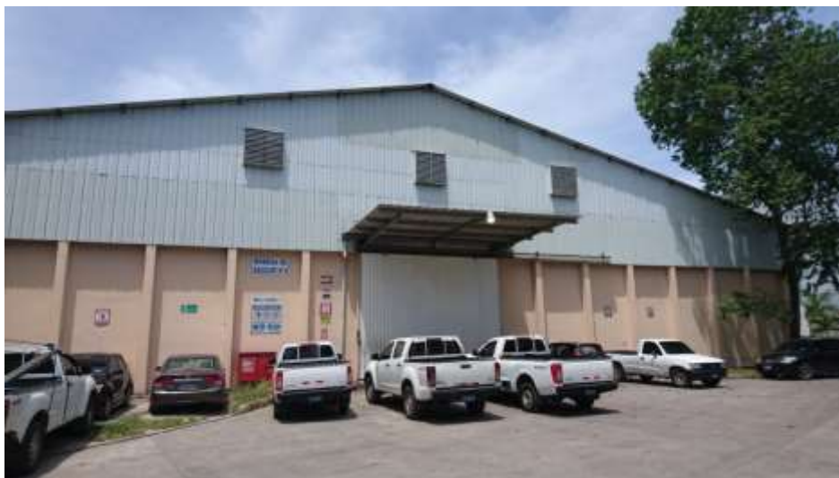
Figura 2.4 Fachada Bodega 4 – Ingenio Azucarero en estudio.
