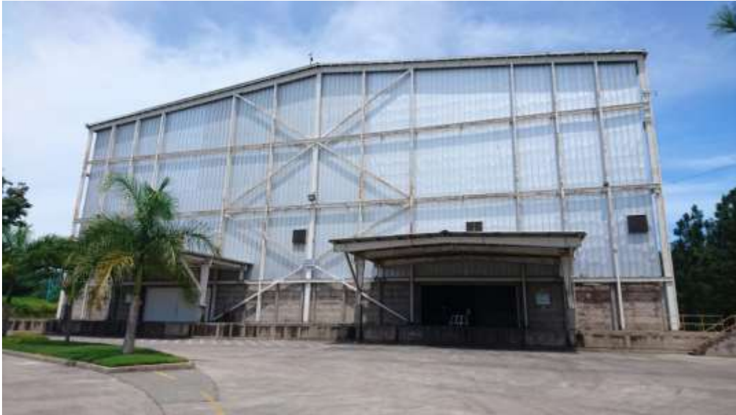
Figura 2.6 Fachada Bodega 5 – Ingenio Azucarero en estudio.
