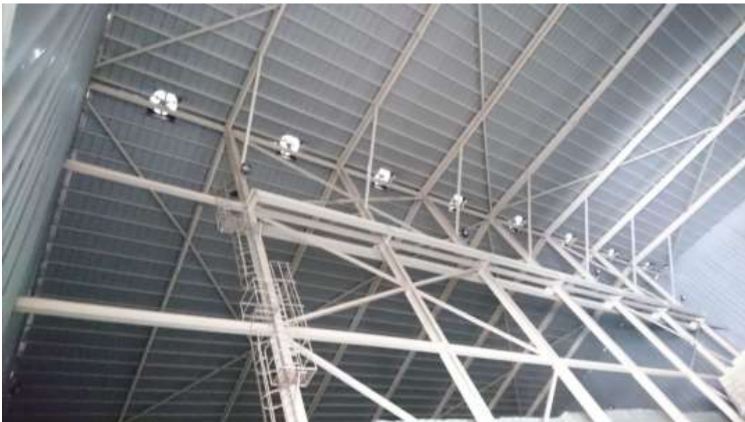
Figura 2.7 Estructura metálica de soporte al centro de la Bodega 5 – Inyectores de aire ubicados en la parte más alta de la bodega.
