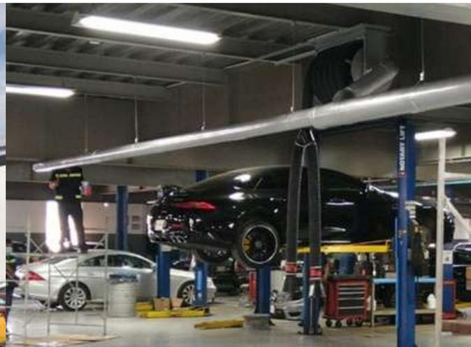
En este proyecto Velyen se sumó al equipamiento para el área de Servicio, en el cual se instaló un extractor de gases con 2 enrolladores mecánicos, cada uno con 7,5 Mts de manguera especial de nylon anti aplastamiento para gases y con una resistencia de hasta 200°C, cada enrollador cuenta con boquereles especiales para la marca MB y se incluyó un adaptador “Y” para los autos con doble escape. Adicional Velyen realizó la instalación e ingeniería para dejar habilitado el sistema dentro del taller.
