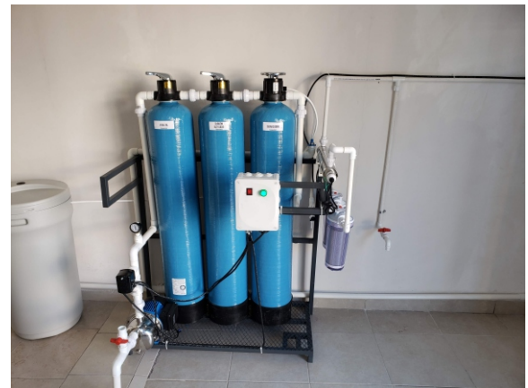
Sistema de tratamiento AQ200
