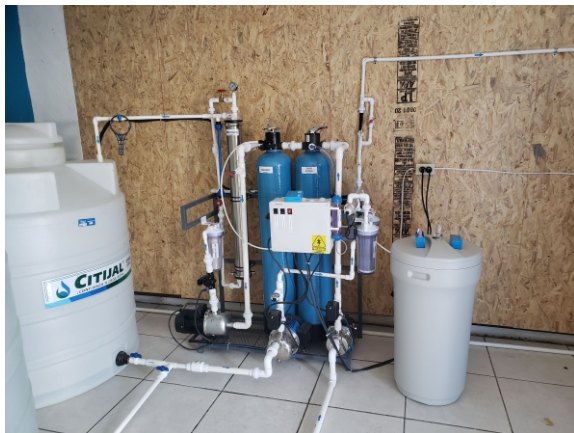
Sistema de tratamiento AQ300
