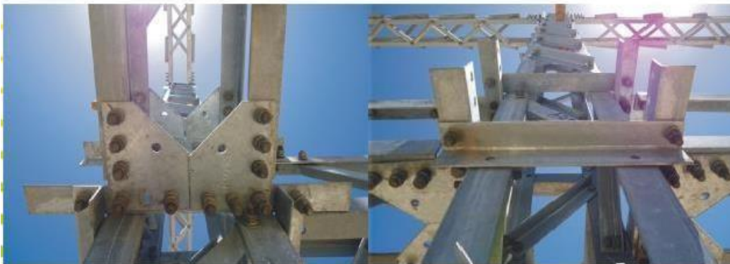
Vista de columnas
