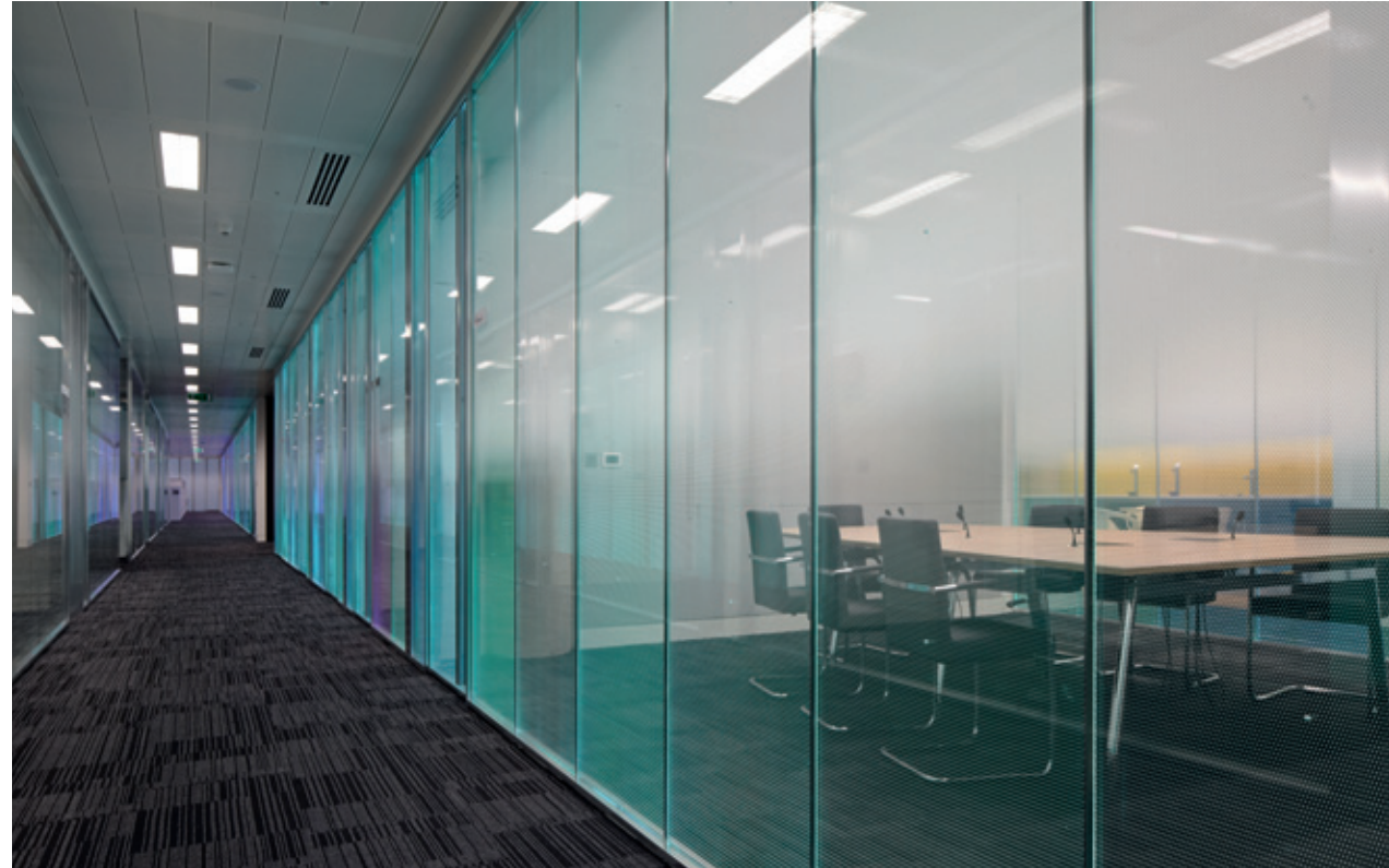
Parete RP con struttura in profilati di alluminio brillantato, pannellatura in vetro trasparente, personalizzata con pellicola di schermatura, e porte scorrevoli a tutta altezza.
