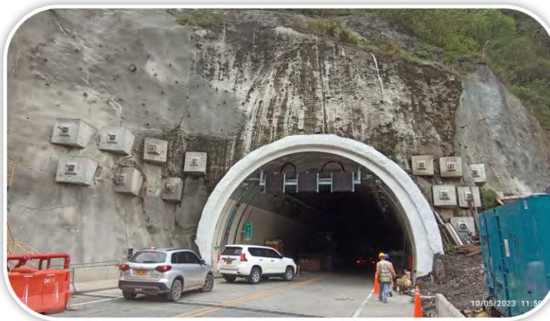
Revestimiento Túnel Fuemia Autopista al Mar 2 Ubicación: Dabeiba, Antioquia. - Agosto 2020
