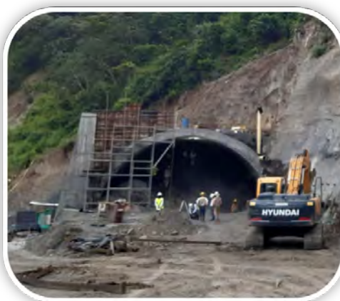
Muro en concreto ciclópeo - Túnel falso y muro de concreto reforzado con ménsula UF2 Vía al Mar 2 Ubicación: Dabeiba Antioquia - Diciembre 2020
